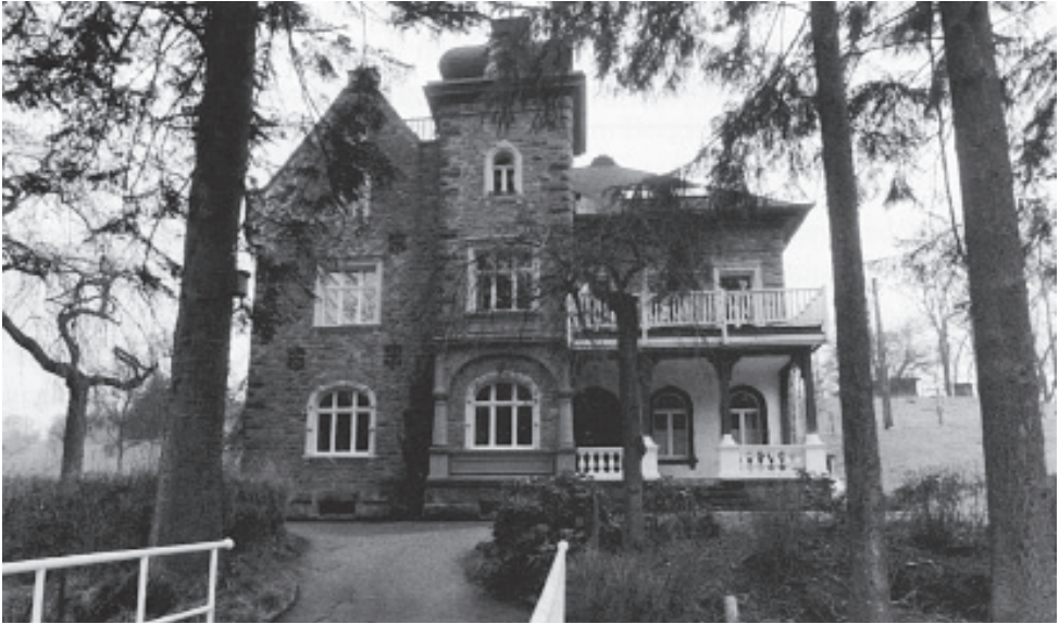
Constantin Breidenbach erbaute 1888/89 „die Burg“ – im Volksmund nach der ehemaligen Junkenburg so genannt – Foto: Heinz Lehmann, Hückeswagen, Archiv: Breidenbach-Führer
